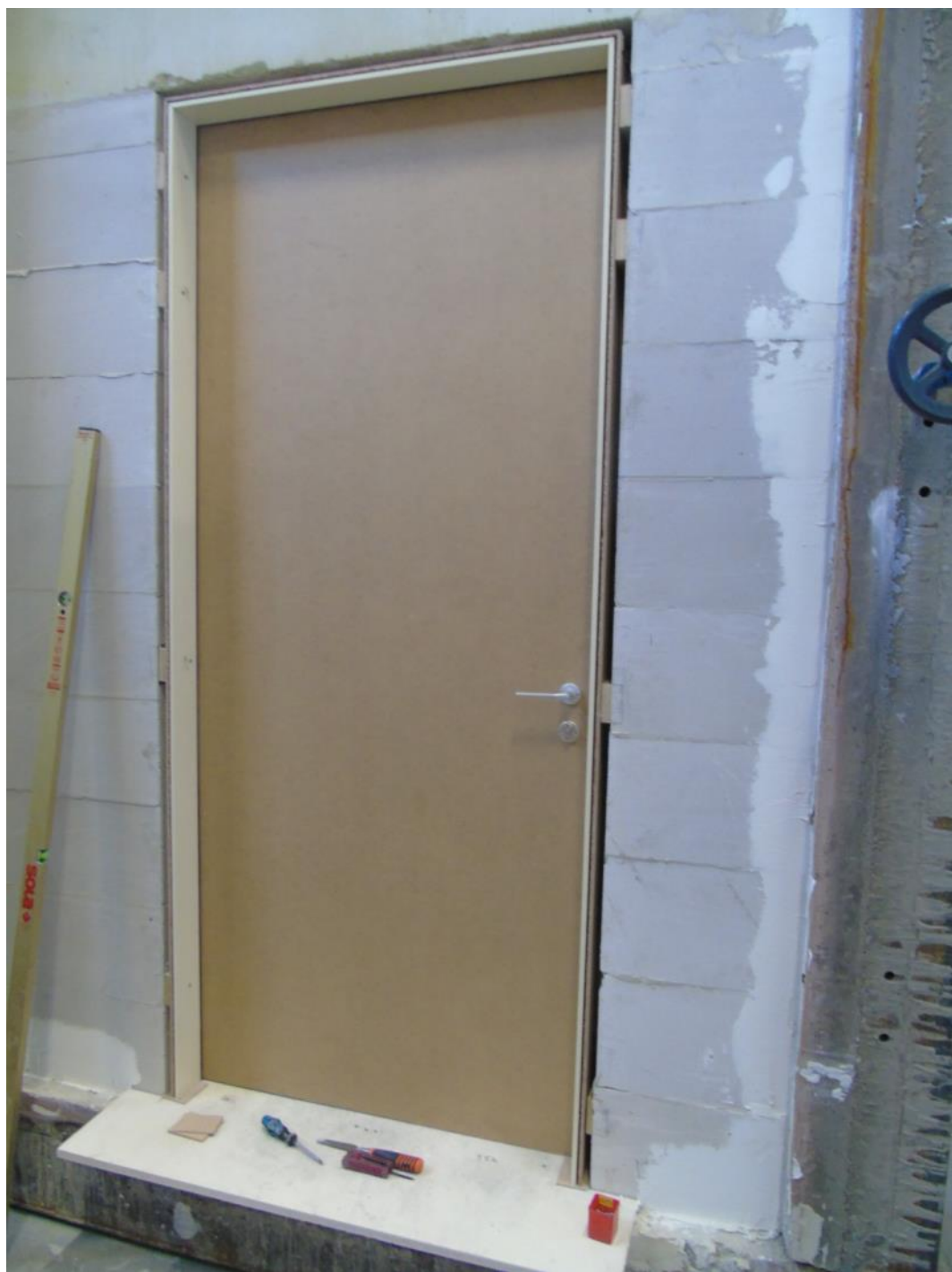
Foto C.3 : kozijn en deur rechter deur in wand
